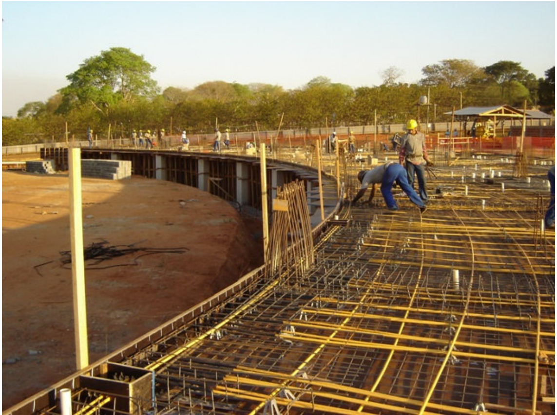
Figura 18 – Laje lisa com cordoalha engraxada
