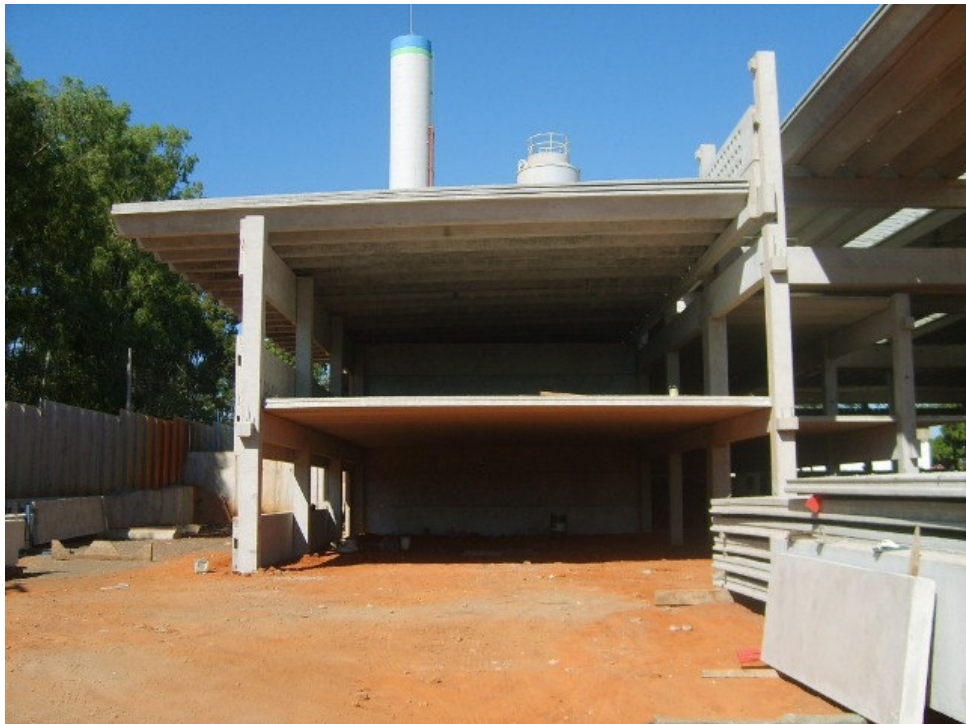
Figura 35 – Laje alveolar bi-apoiada em vigas pré-moldadas
