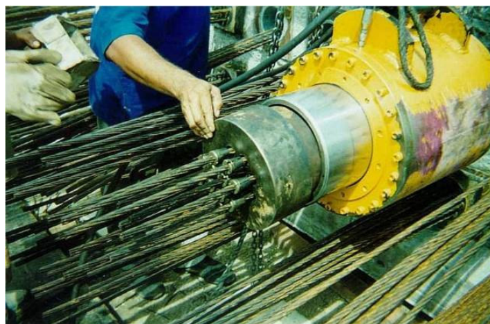
Figura 13 – Montagem de macaco hidráulico para protensão
