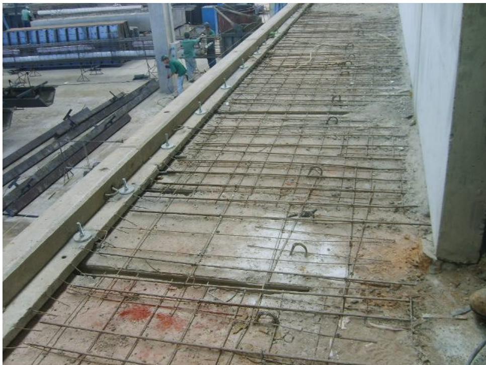
Figura 39 – Trecho de laje em balanço e detalhe da tela da capa
