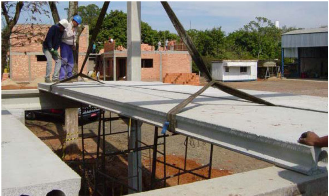
Figura 23 – Posicionamento de laje alveolar com auxílio de fita
