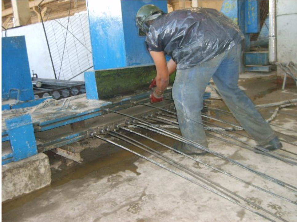
Figura 25 – Fixação de cordoalhas
