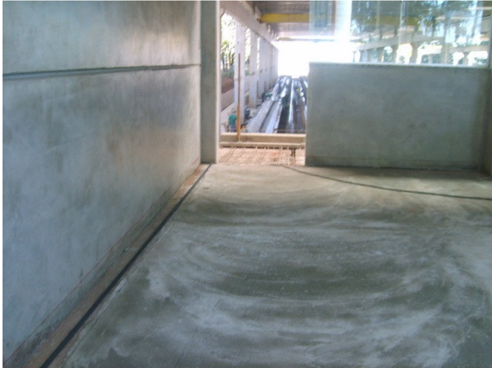
Figura 40 – Laje alveolar com capa de concreto polido
