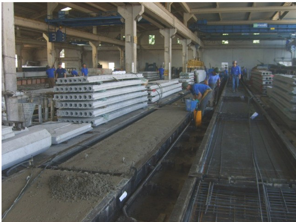
Figura 33 – Acabamento de laje alveolar
