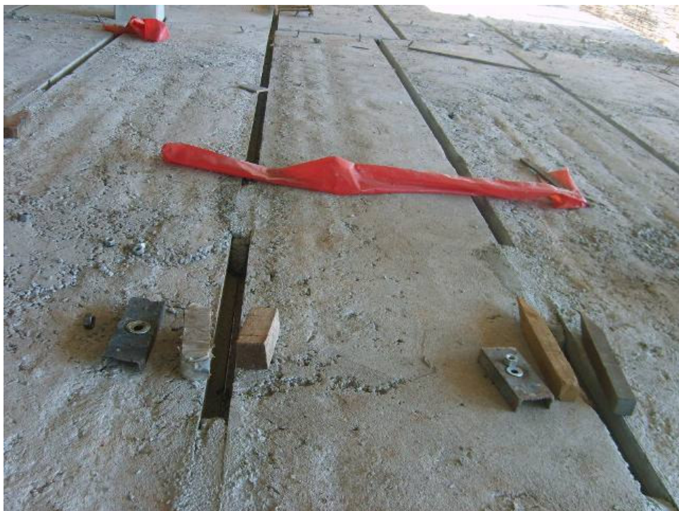
Figura 37 – Conclusão da etapa de nivelamento entre as lajes alveolares
