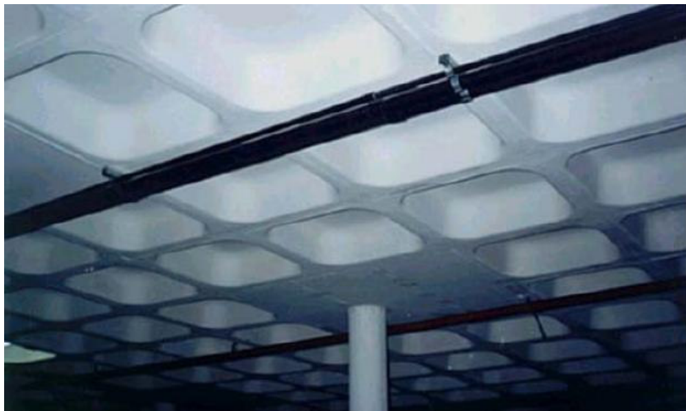
Figura 17 – Laje nervurada construída com formas de polipropileno
