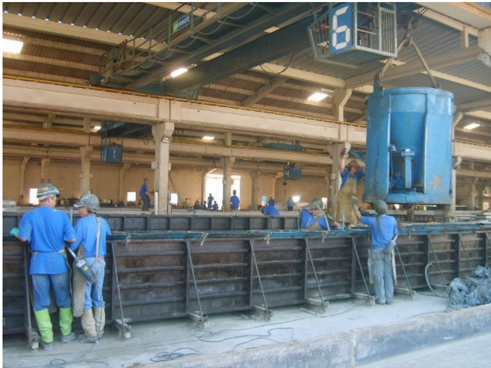
Figura 31 – Lançamento de concreto em viga retangular
