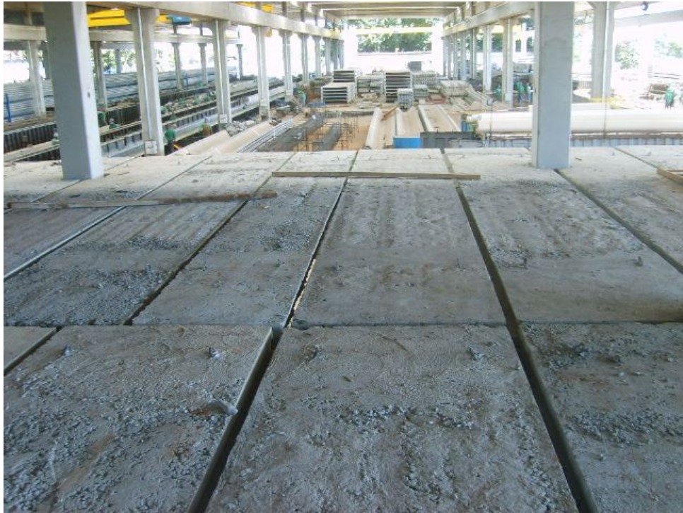
Figura 36 – Lajes alveolares montadas no pavimento
