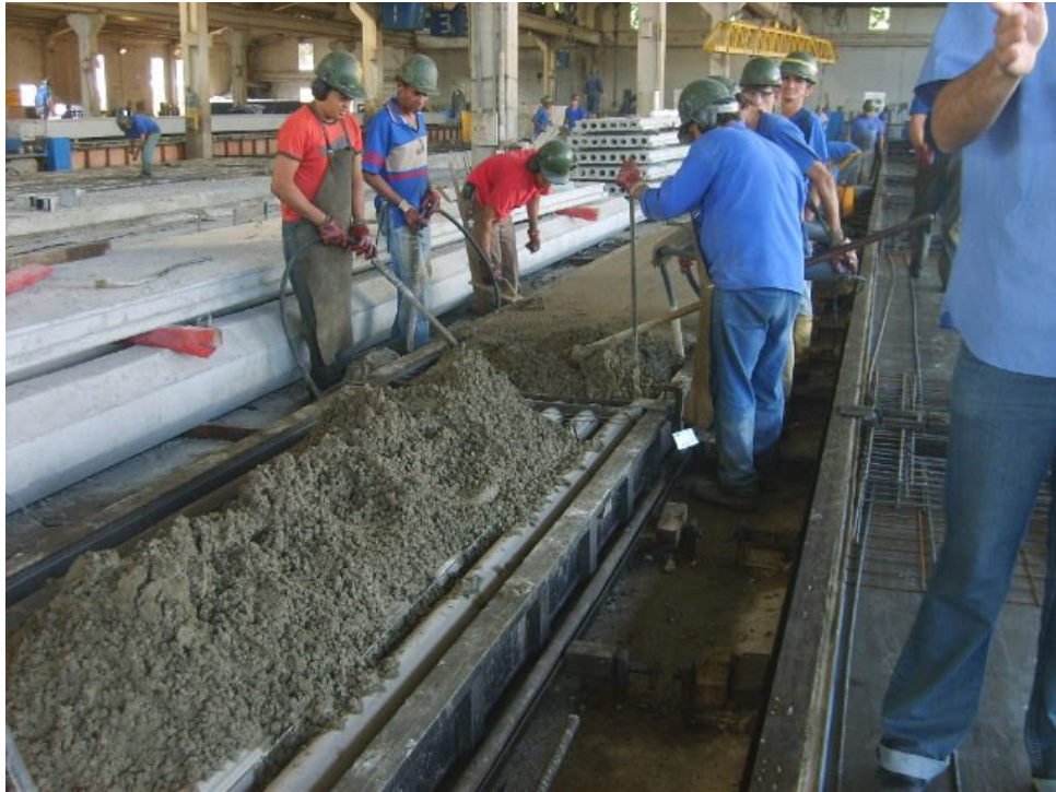
Figura 32 – Concretagem de laje alveolar
