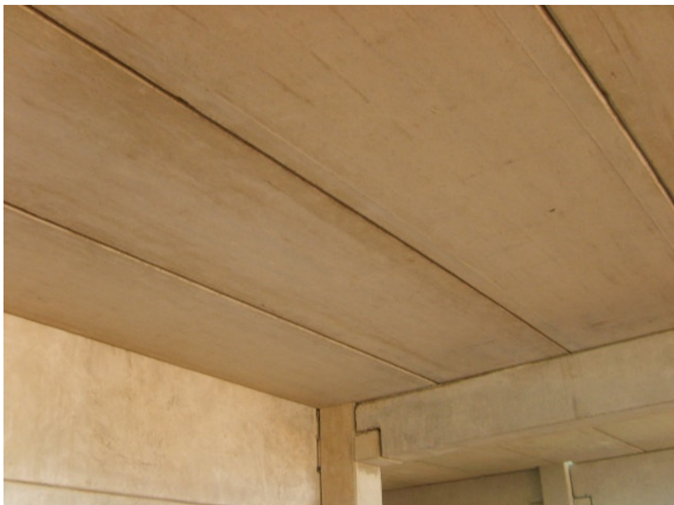
Figura 41 – Vista por baixo das lajes alveolares acabadas
