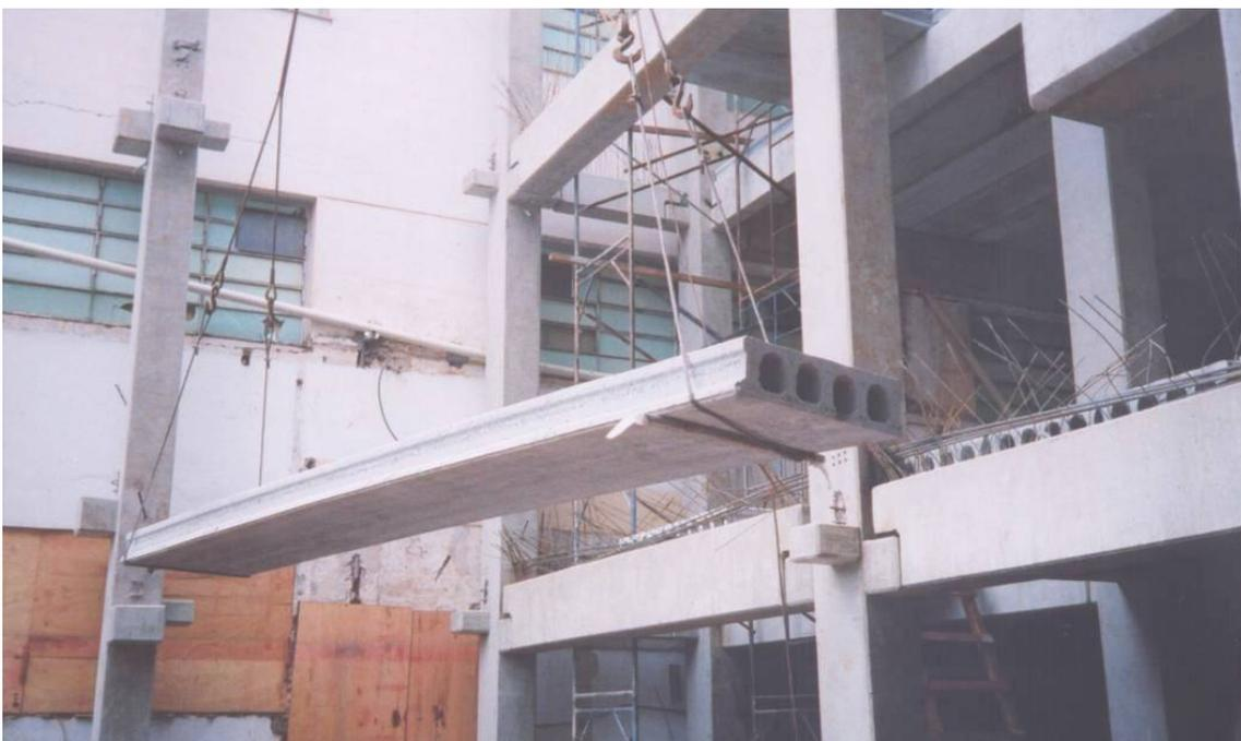
Foto 3 – Detalhes de montagem incluindo o posicionamento da armadura de continuidade das vigas do pavimento mais inferior apresentado.
