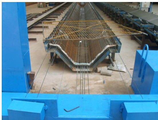
Estacas, vigas, telhas, lajes e painéis.
