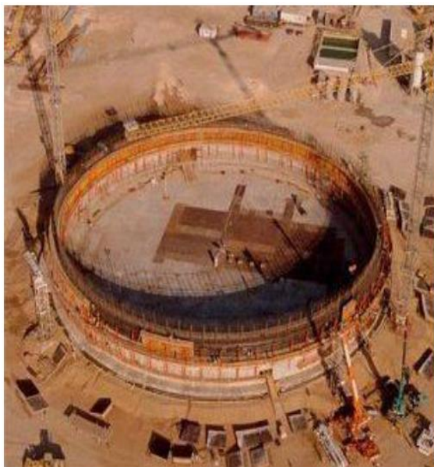
Figura 3 – Fôrma trepante
