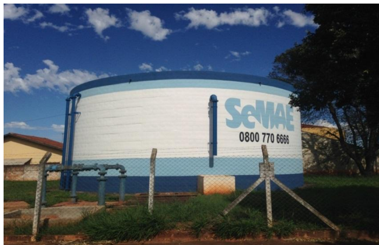
Figura 11 – Reservatório circular ao nível do solo
