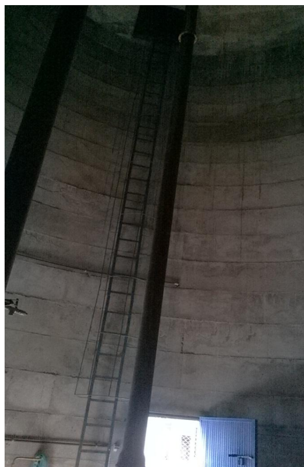
Figura 16 – Vista interna do reservatório
