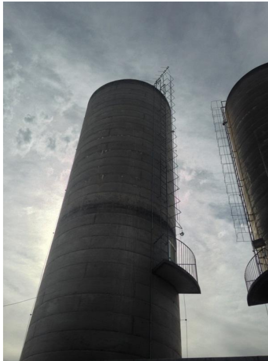
Figura 10 – Reservatório cilíndrico elevado
