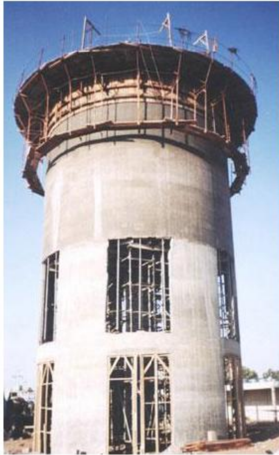
Figura 4 – Fôrma deslizante
