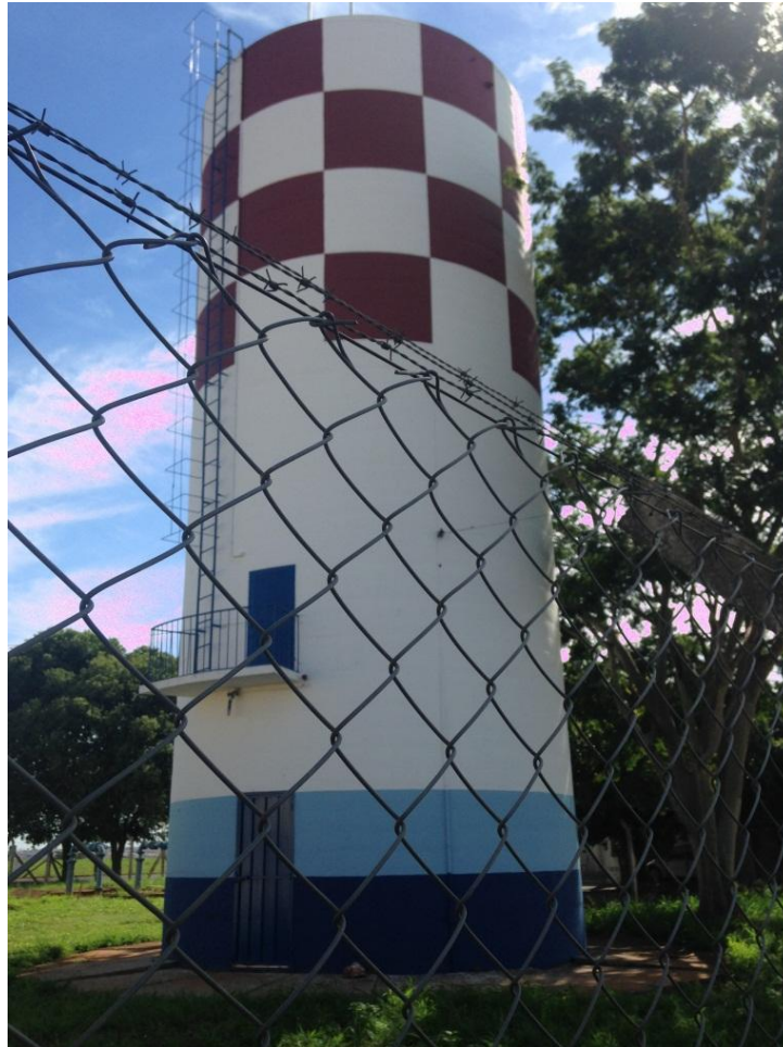
Figura 13 – Reservatório circular elevado
