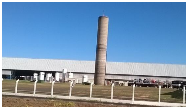
Figura 14 – Reservatório cilíndrico em Votuporanga-SP
