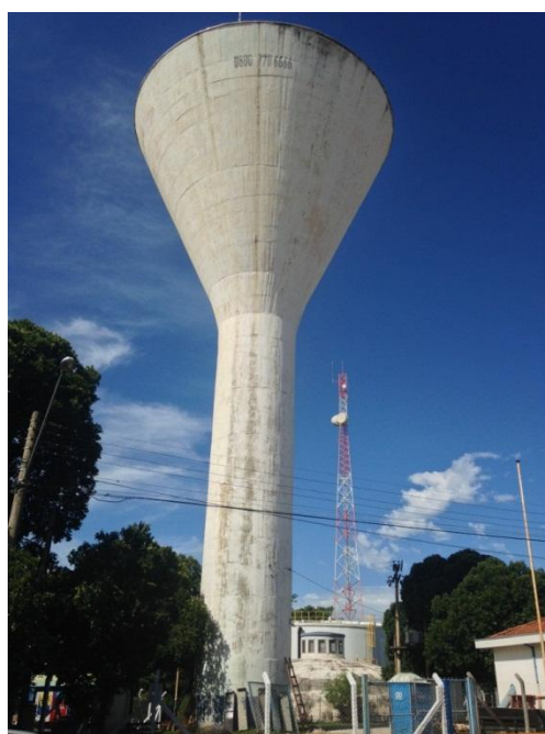
Figura 12 – Reservatório cilíndrico elevado em forma de tulipa
