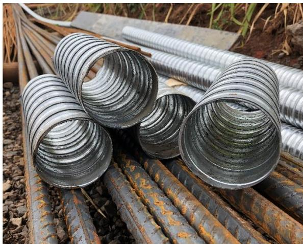
(b) bainhas posicionadas durante a etapa de montagem da armadura da viga pré-moldada
