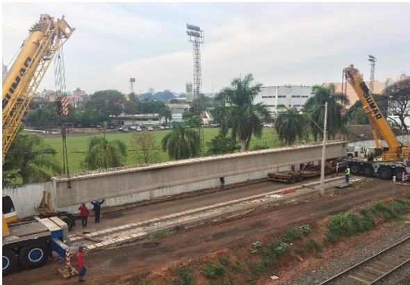
(b) montagem de longarina de 35 m sobre as travessas com auxílio de dois guindastes
