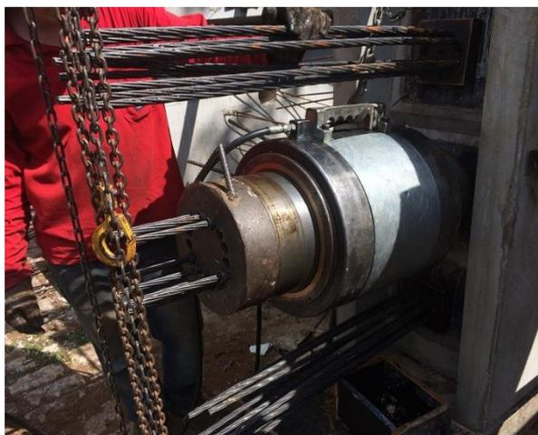
(b) cabos fixados em placas de ancoragem
